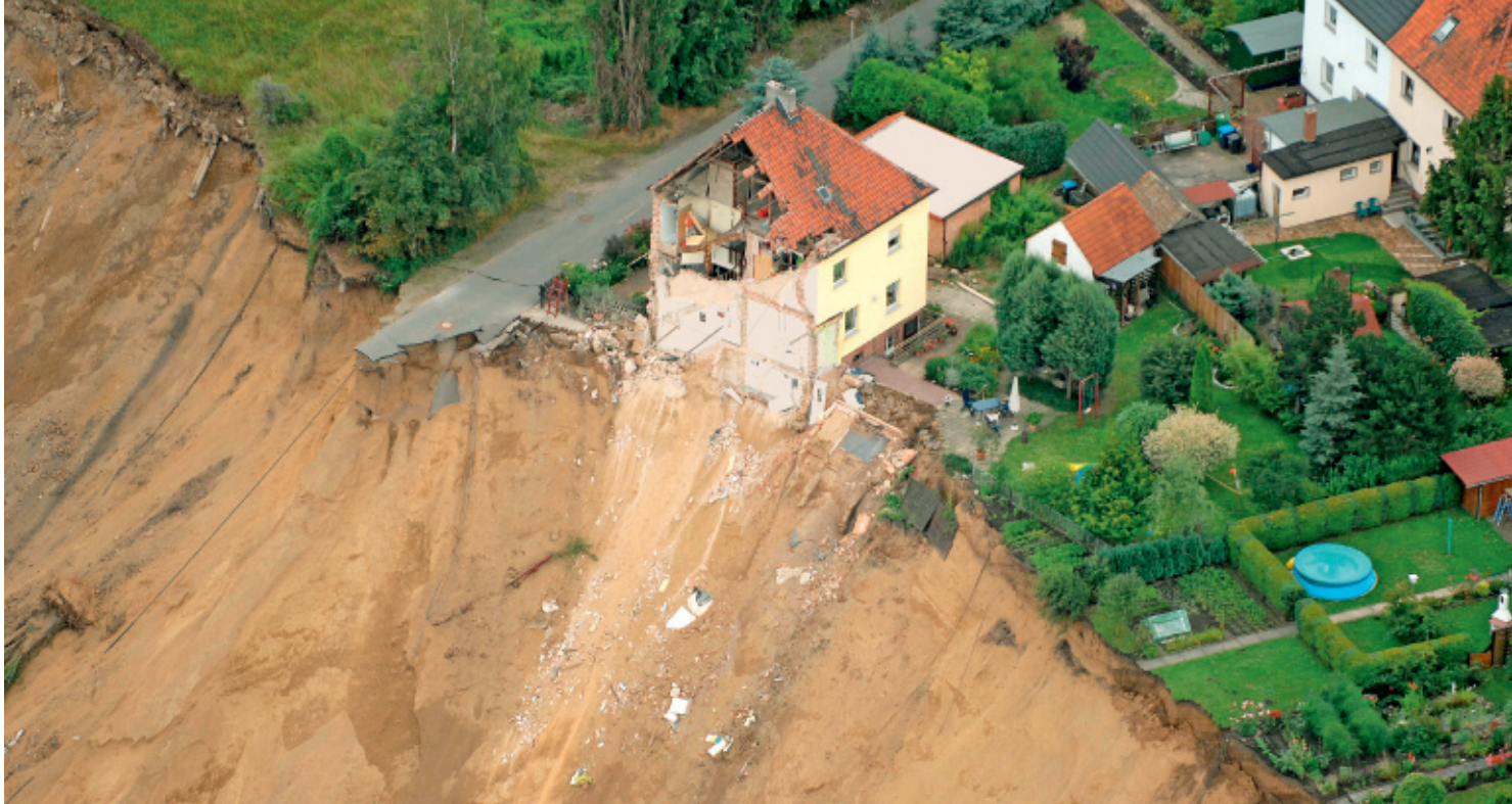
Die Naturkatastrophe von Nachterstedt in Sachsen-Anhalt zeigt, wie wichtig die Forschung an nassen Sanden ist: Im Juli 2009 rutschte dort ein Uferstück eines Tagebausees ab und riss zwei Häuser mit drei Bewohnern in die Tiefe.
